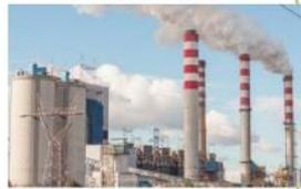
Dans les centrales thermiques à flamme, du charbon, du pétrole ou du gaz naturel sont brûlés : l'énergie chimique des combustibles est convertie en énergie thermique.
