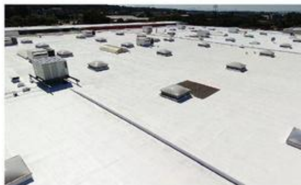
La société bretonne Cool Roof a utilisé une résine blanche pour peindre le toit de ce grand magasin.
