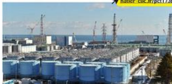
Les cuves de stockage de l'eau radioactive ayant servi à refroidir les réacteurs de Fukushima.
